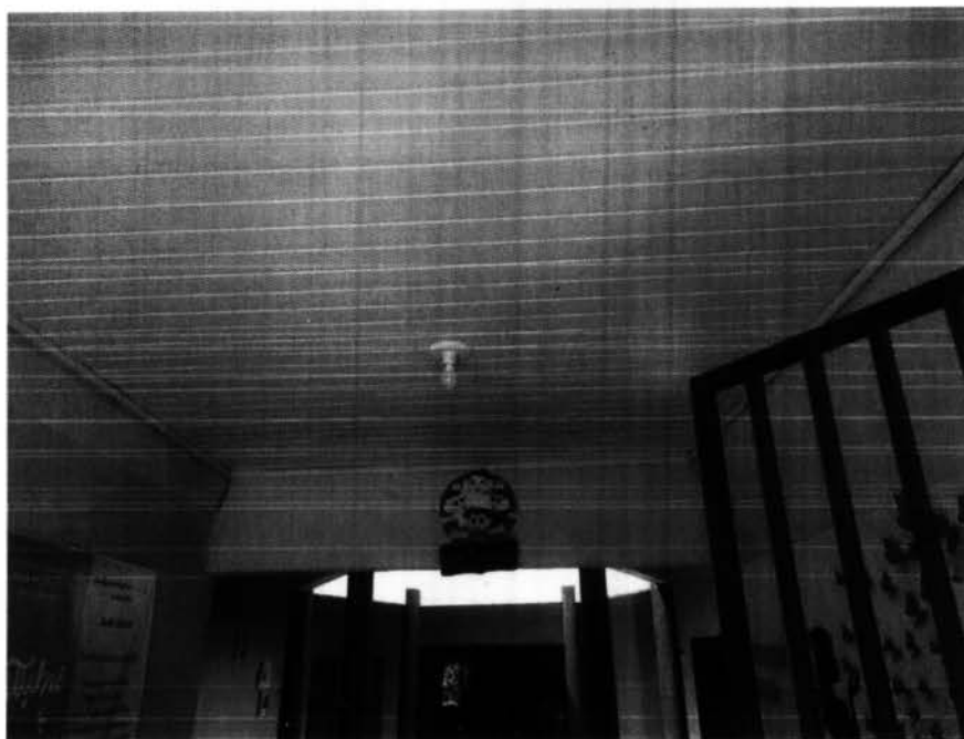
Imagem 5 – Instalação do forro pvc no hall da entrada da escola.
