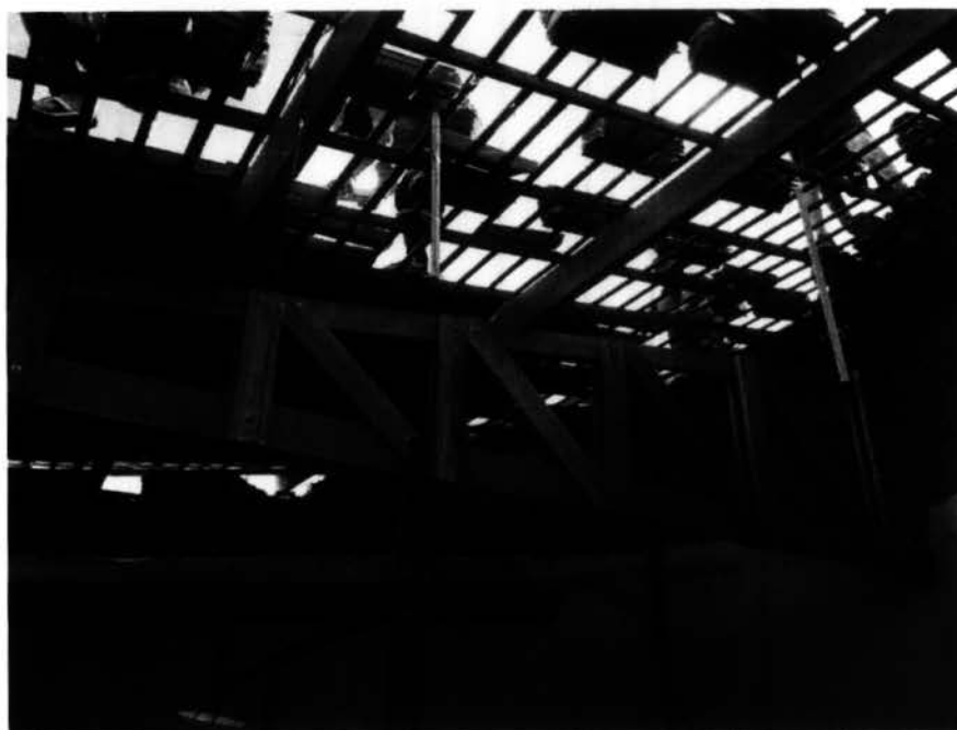
Imagem 4 – Execução da tesoura de madeira nas salas de aula.
