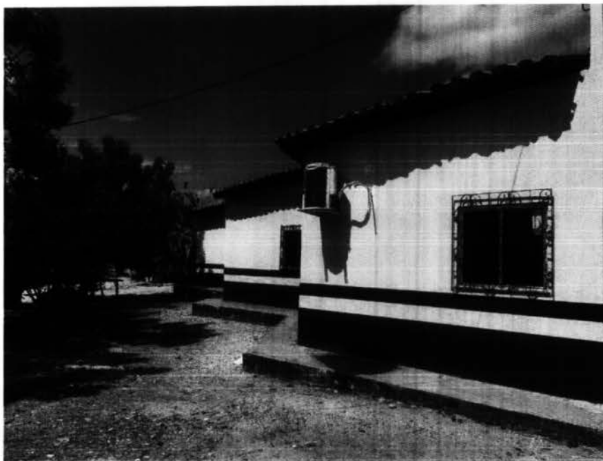
Imagem 3 – Pintura da fachada da escola.
